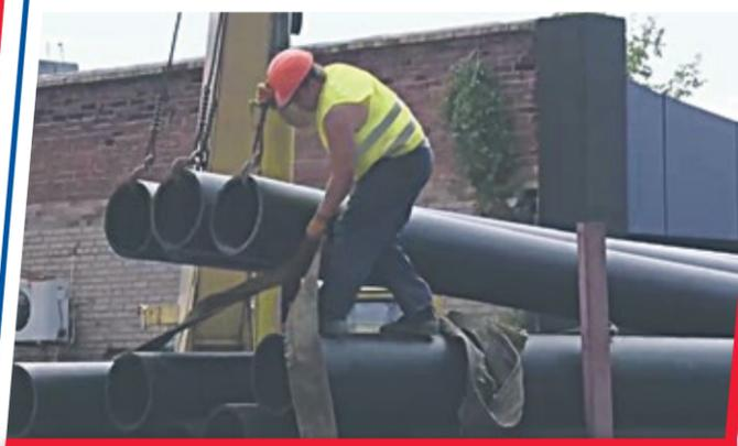
При поддержке региона-шефа на территории макеевского микрорайона Зеленый меняют инженерные коммуникации. Капремонту подлежат 3 километра водопроводных и 570 метров канализационных сетей. Замена трубопроводов позволит значительно сократить количество порывов на территории города и обеспечит стабильную подачу воды населению.
